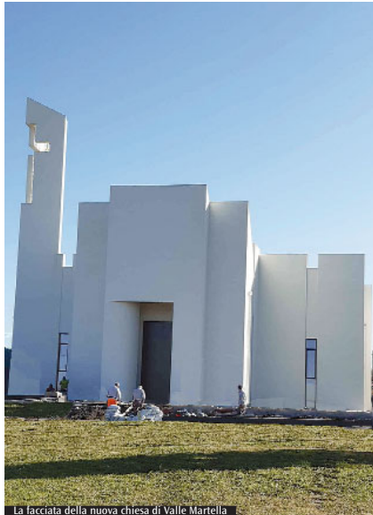
La facciata della nuova chiesa di Valle Martella
